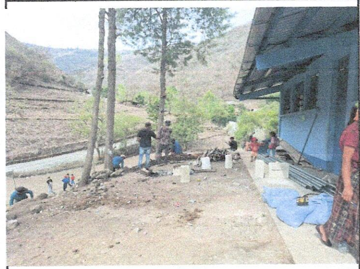
Foto 4: Mejoramiento del Cerco o muro Perimetral
