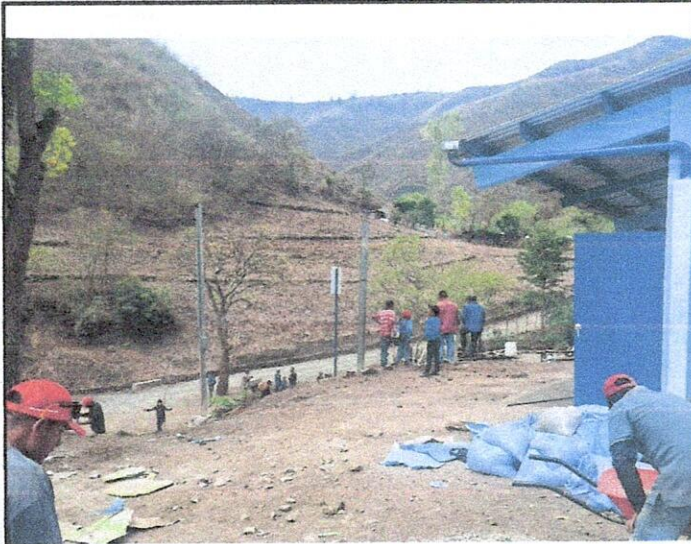
Foto1: Mejoramiento del Cerco o muro Perimetral
