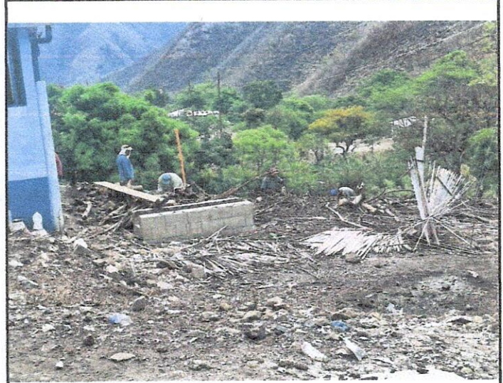
Foto 2: Mejoramiento del Cerco o muro Perimetral
